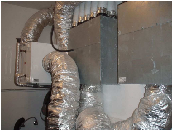
fehér doboz a kalorifer, Alu dobozok a légcsatorna osztó és gyűjtő
